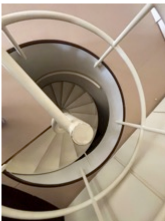
Treppe in die Techniketage
