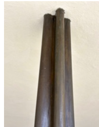
Stahlstütze im Außenbereich
