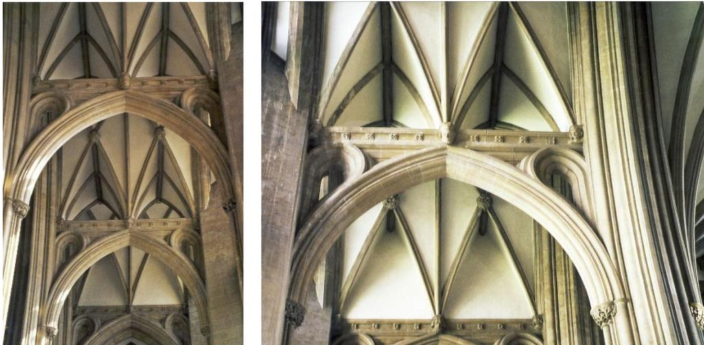
**Abb. 13 und 14 Bristol, ehem. Stiftskirche, Chor, Seitenschiff, Schwibbogen-Strebekonstruktion**
