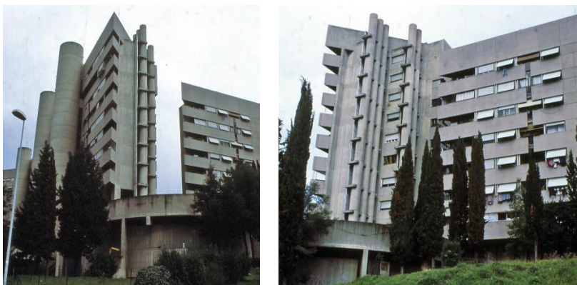
Abb. 13 und 14 Rom, Stadtquartier Vigne Nuove, Außenansichten
