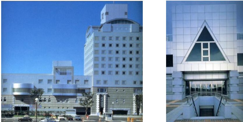
Abb. 4 und 5 Tsukuba/Japan, Bürgerzentrum, Arata Isozaki 1979-83, L-förmige Randbebauung
