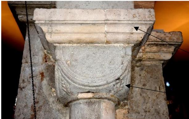
Die attischen Basen dieser Rundvorlagen werden im Sockelprofil der Pfeiler in Form von Wulst-Kehle-Wulst ausgeführt und enden im oberen Bereich in verkröpften Gesimsen aus Viertelstab, Kehle und abschließender Platte. Die Würfelkapitelle der Rundvorlagen wiederum zeigen Halbkreisschilde mit Palmettendekors in den beiden Zwickelbereichen.
