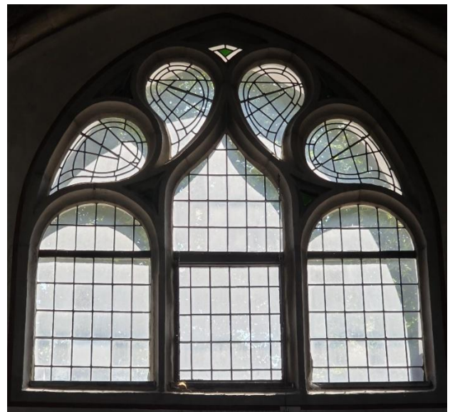
Abb. 64: Fenster des Obergadens
