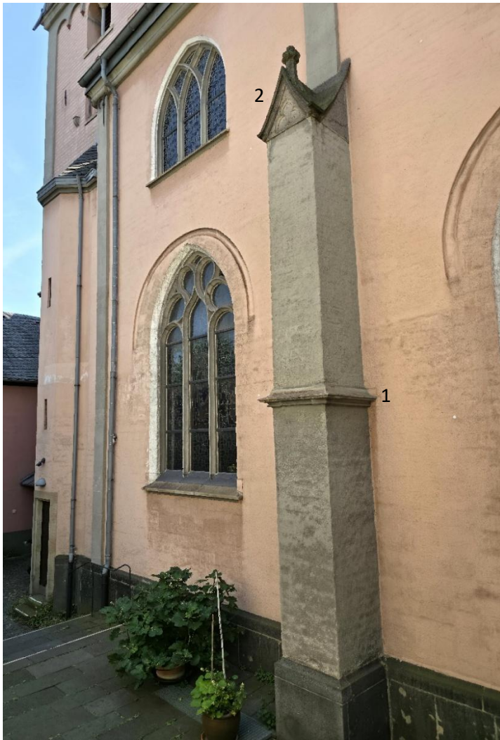
Abb. 11: östliches Langhausjoch der Nordfassade
