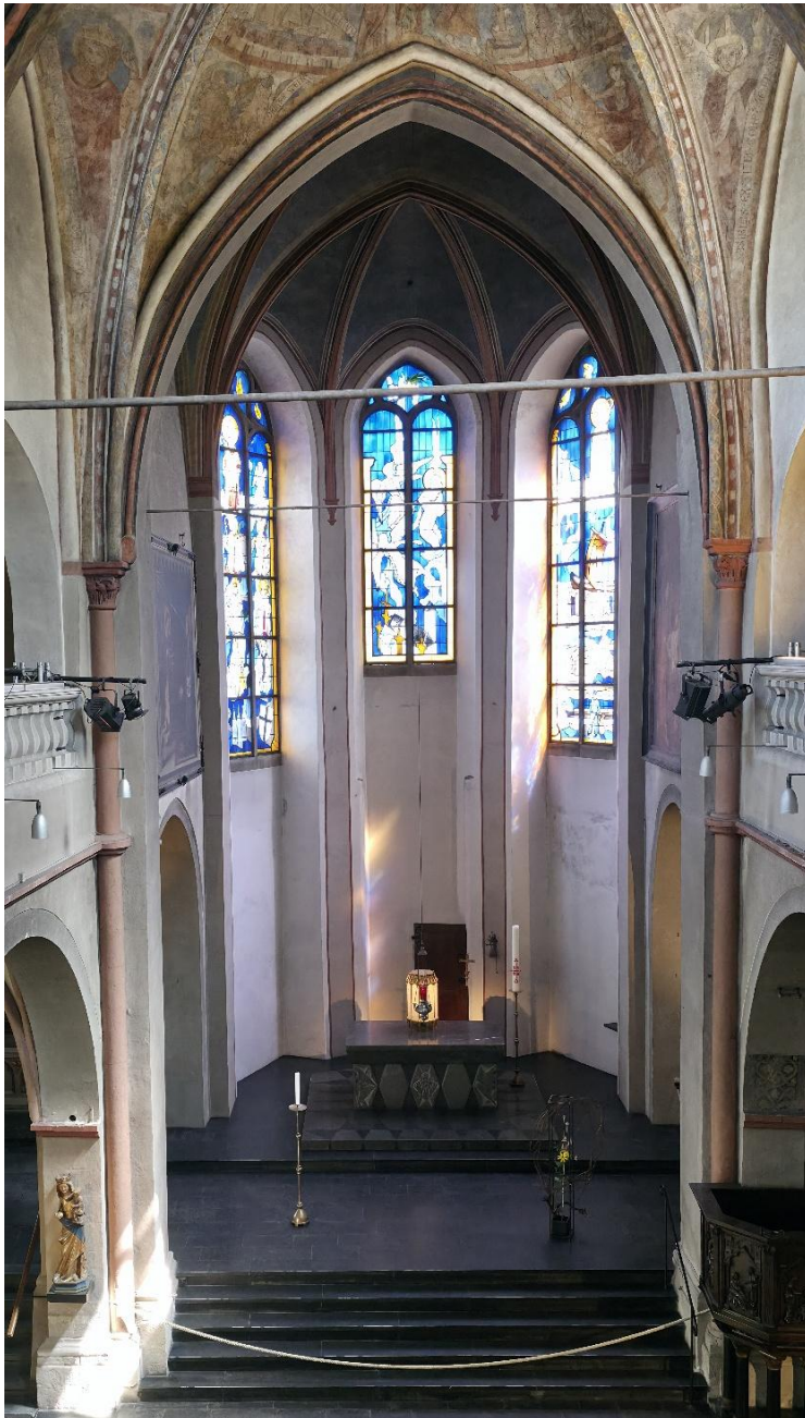
Abb. 30: erhöhtes Chorjoch mit polygonal gebrochener Apsis
