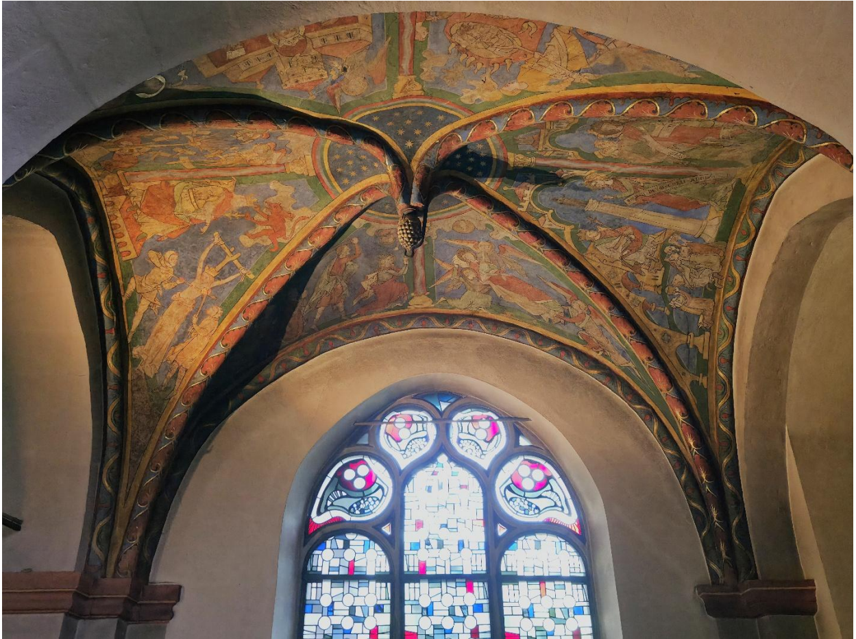
Abb. 36: Katharinenkapelle: romanisches Wulstrippengewölbe mit hängendem Schlussstein
