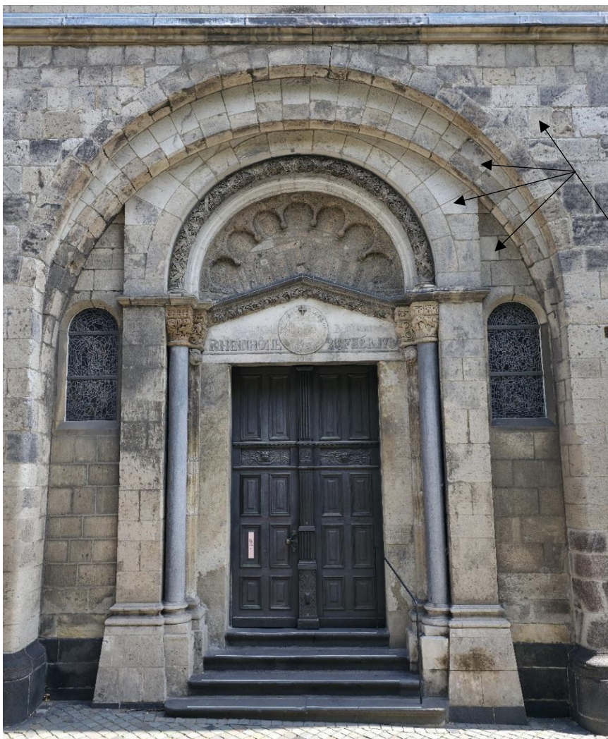
Abb. 9: mehrschaliges Hauptportal der Westfassade
