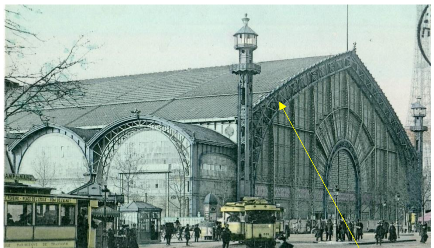
Abb. 6: Galerie des Machines von 1889 mit zweiteiligem Dreigelenkbinder [3]
