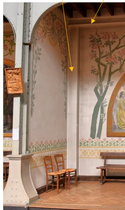
Abb. 44: Aufbau der Eisenpfosten und Abb. 45: Eisenträger der Außenmauer (Fotos R. Vlatten, 2023)
