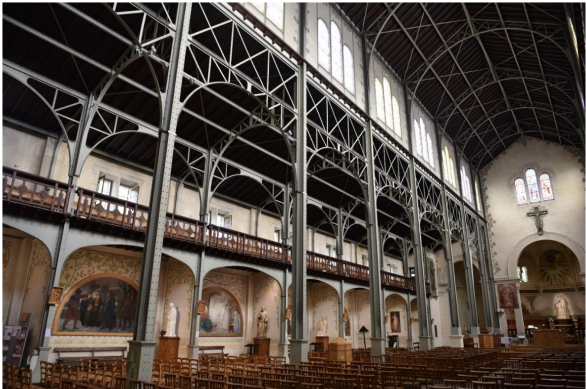
Abb. 48: Etagenabfolge Kapellen/Empore – Seitenschiff – Hauptschiff – Dachstuhl (Foto R. Vlatten, 2023)
