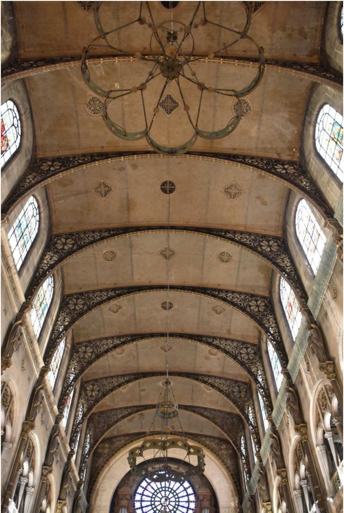
Abb. 72: Gewölbeflucht im Langhaus
