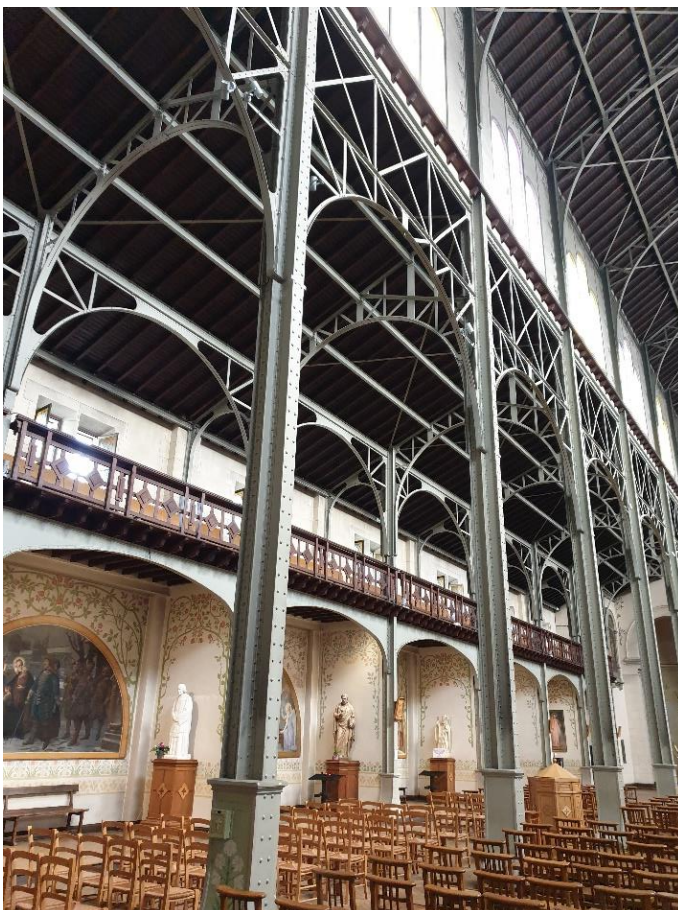
Abb. 36: Dachkonstruktion Seitenschiff und Empore
