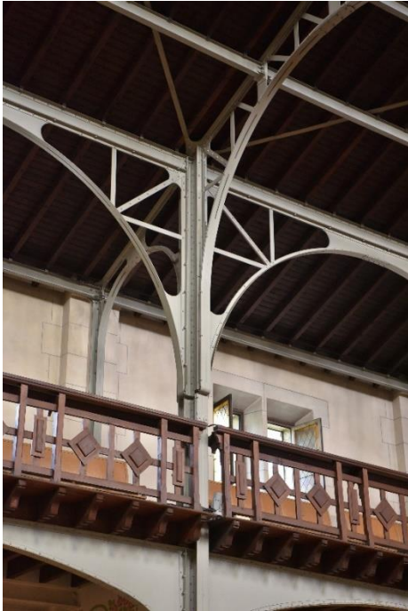
Abb. 46: Verbindung Empore / Seitenschiff und Abb. 47: Verbindung Seiten- / Hauptschiff (Fotos R. Vlatten, 2023)
