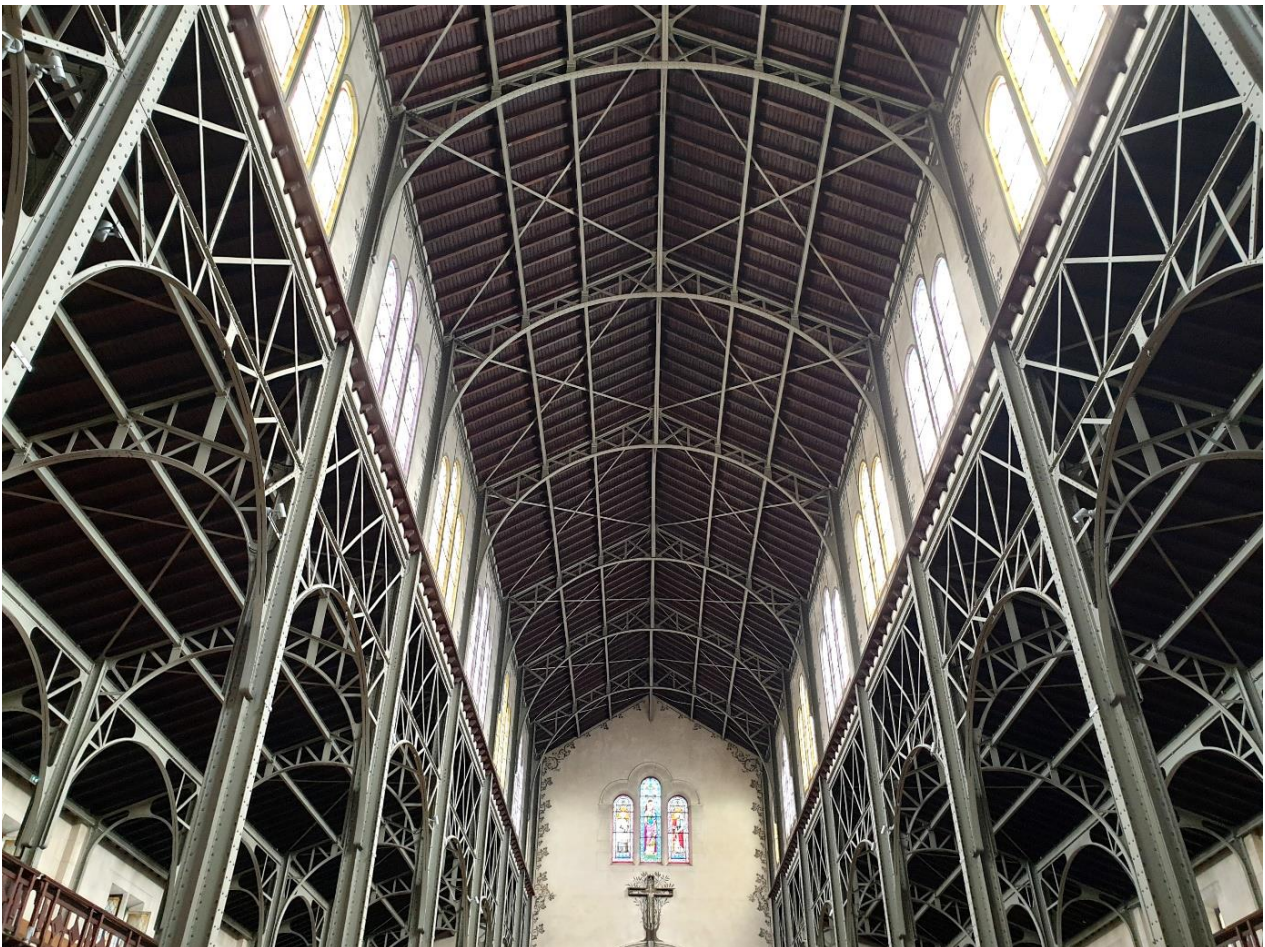
Abb. 59: Dachkonstruktion mit Obergaden und Scheidbögen mit Blickrichtung zum Chor
