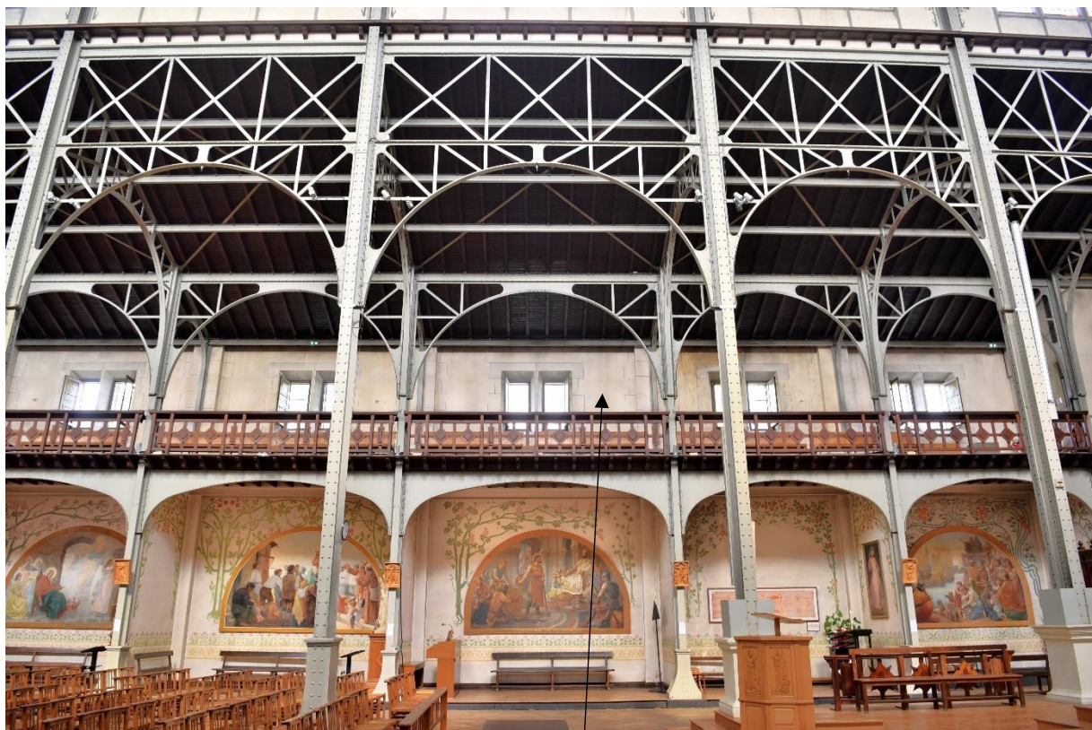
Abb. 55: Aufbau des Seitenschiffs mit Kapellenabfolge, Galerie und Eisenskelettgerüst
