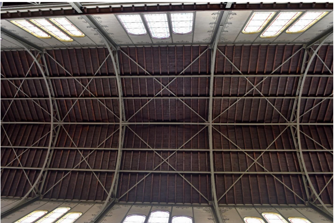
Abb. 49: Eisenkonstruktion des Dachstuhls (Foto R. Vlatten, 2023)
