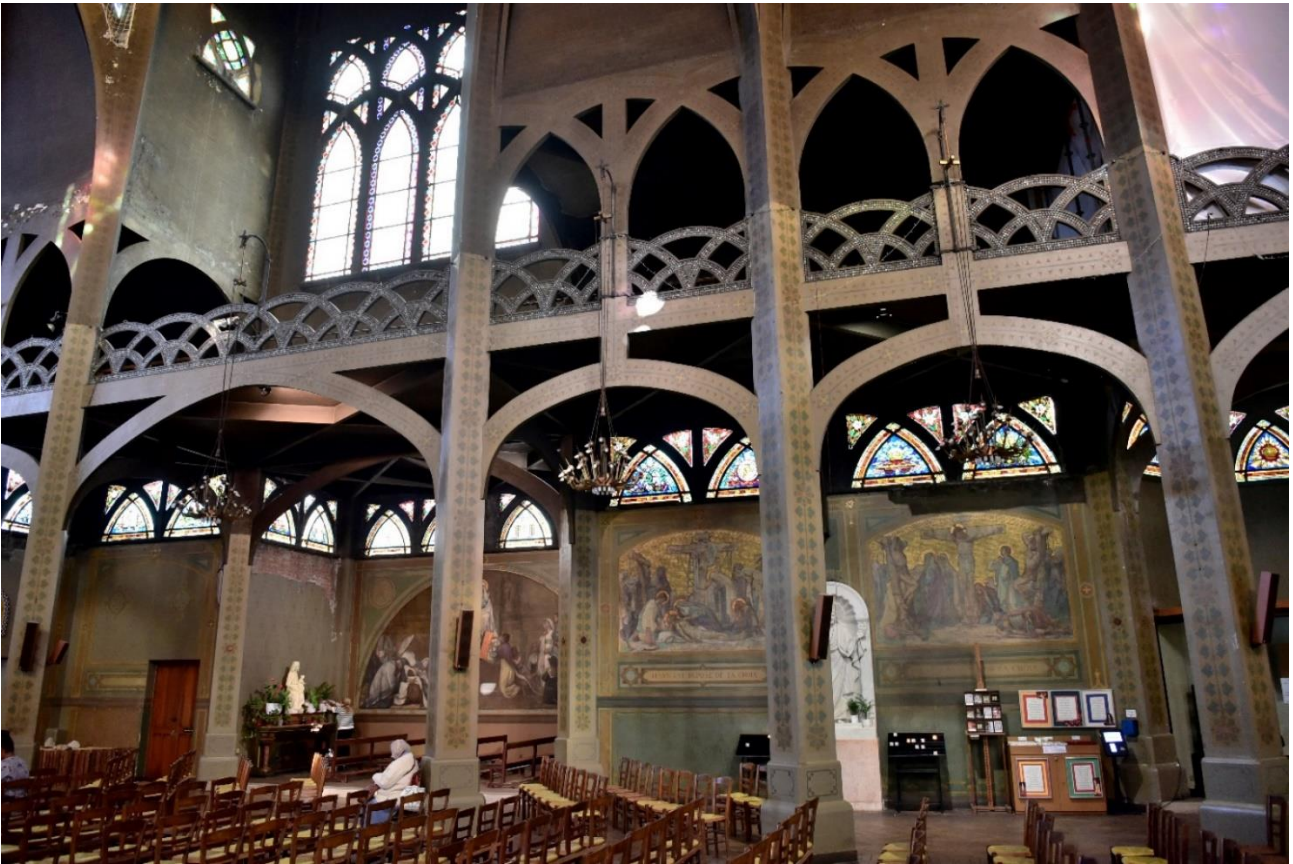
Abb. 81: Stahlbetonskelett gliedert Seitenschiff mit Empore
