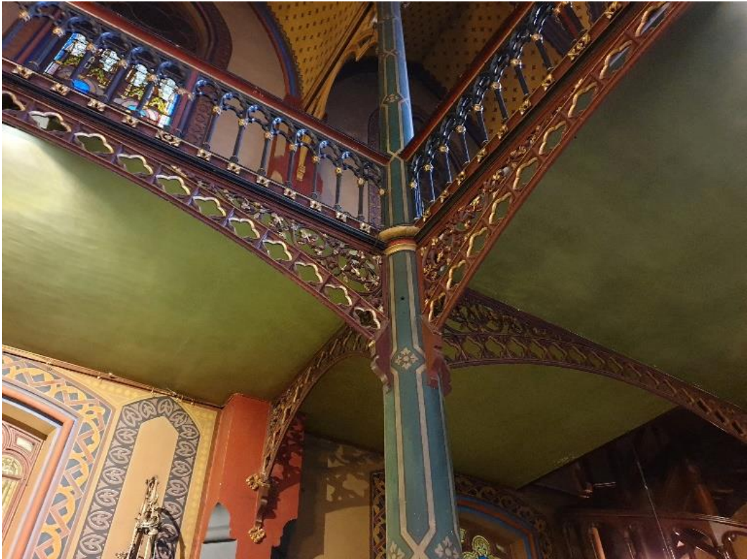
Abb. 67: Tragkonstruktion am Übergang Seitenschiff / Kapelle / Empore mit eisernen Schwibbögen
