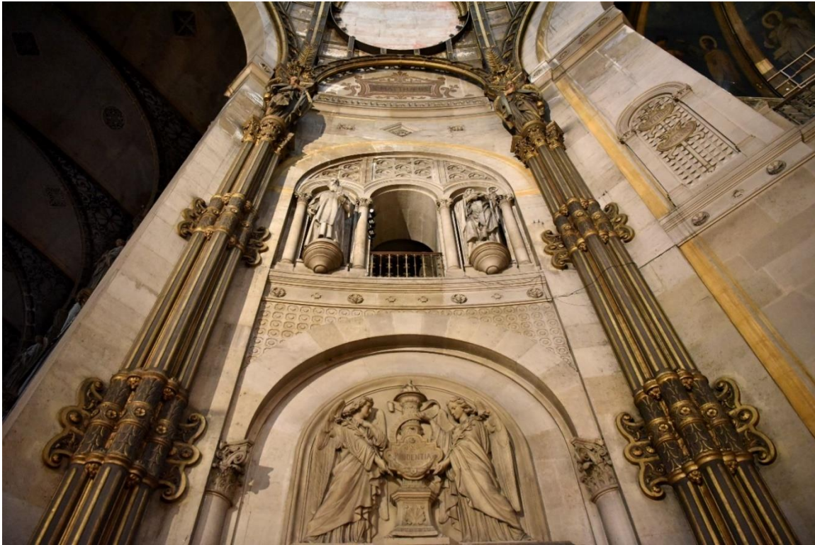
Abb. 79: gebündelte Vorlagensysteme in der Vierung mit ornamentierten Wandbefestigungen
