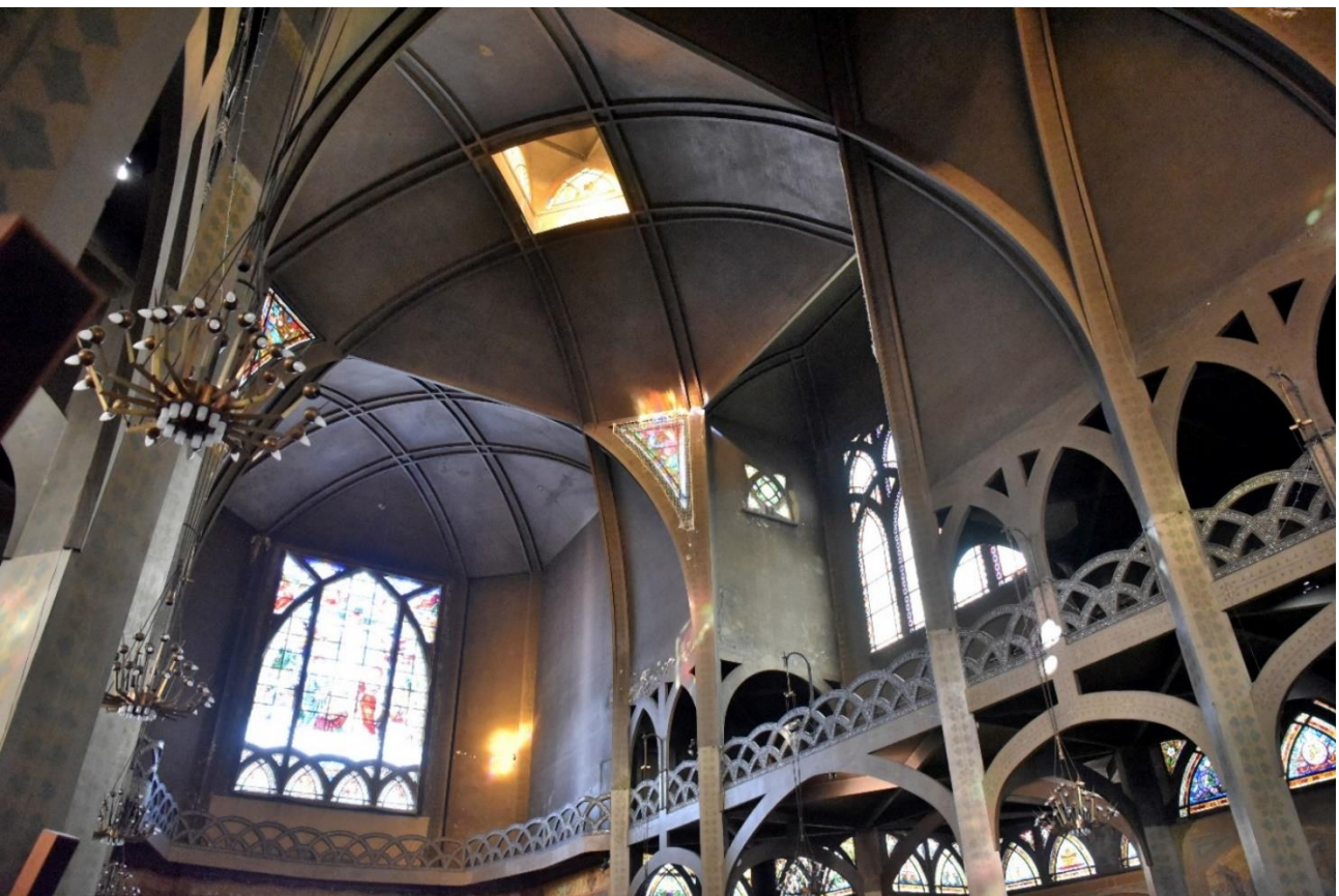
Abb. 82: Gewölbekonstruktion am Übergang vom Langhaus zum Chor
