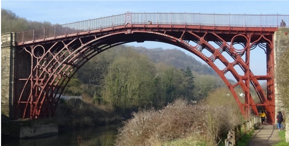
Abb. 11: Die Coalbrookdale Bridge über den Severn in den West Midlands als Bogentragwerkbrücke [7]
