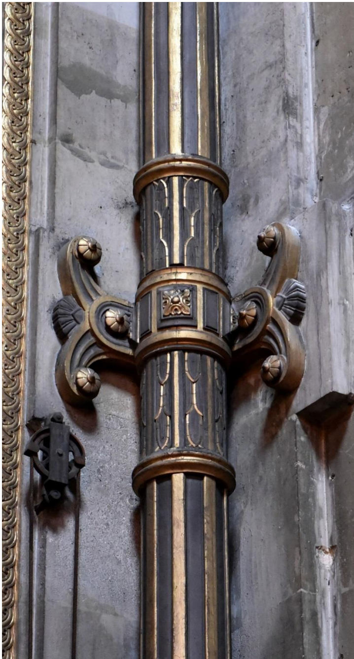
Abb. 75 und 76: Eisenpfeiler im Langhaus mit verzierten Wandbefestigungen und metallenen Leuchten
