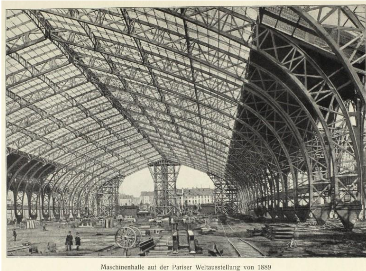
Abb. 7: Dreigelenkbogenbinder der Galerie des Machines [4]
