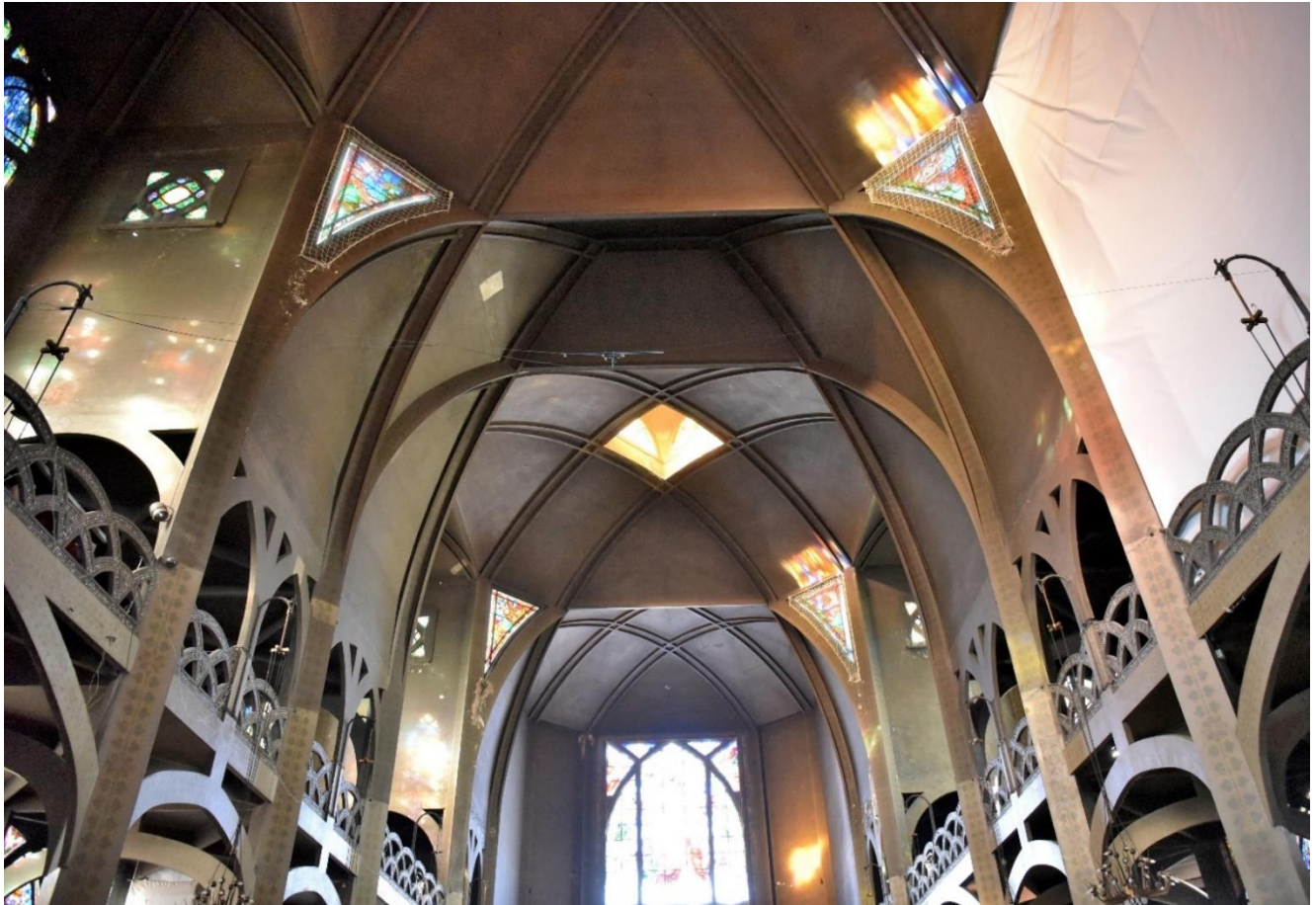
Abb. 83: aufstrebende Stahlbetonkonstruktion mit Blickrichtung zum Chor
