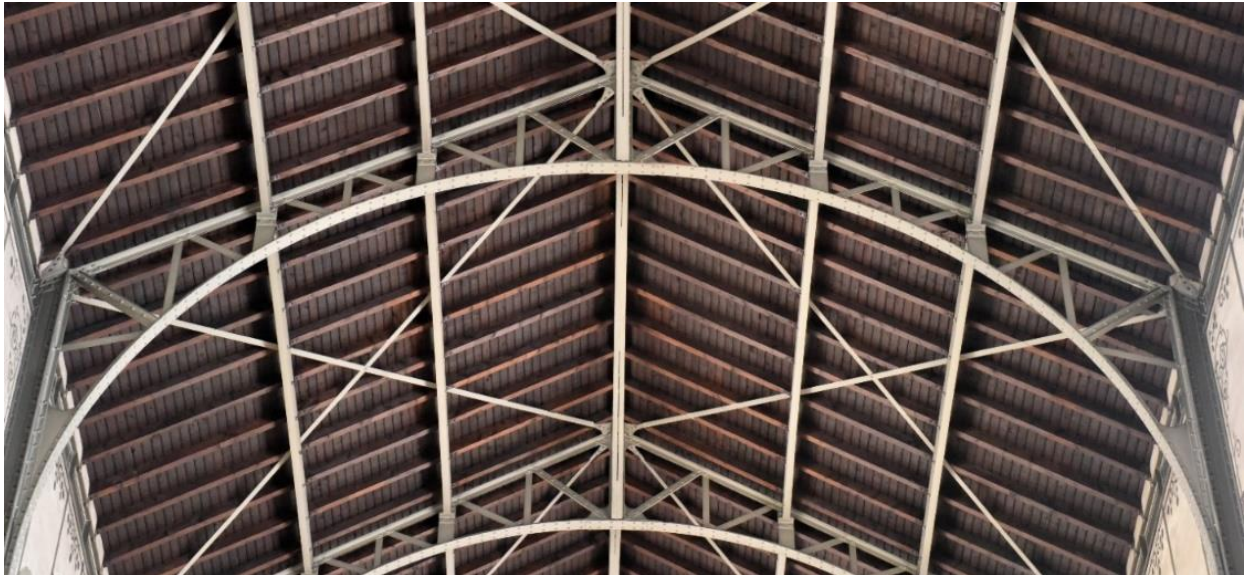
Abb. 50: Eisenkonstruktion des Dachstuhls, Detail (Foto R. Vlatten, 2023)
