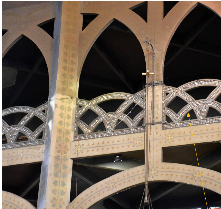
Abb. 89: Detailansicht der innen hohlen Stahlbetonkonstruktion und Mosaikverzierungen
