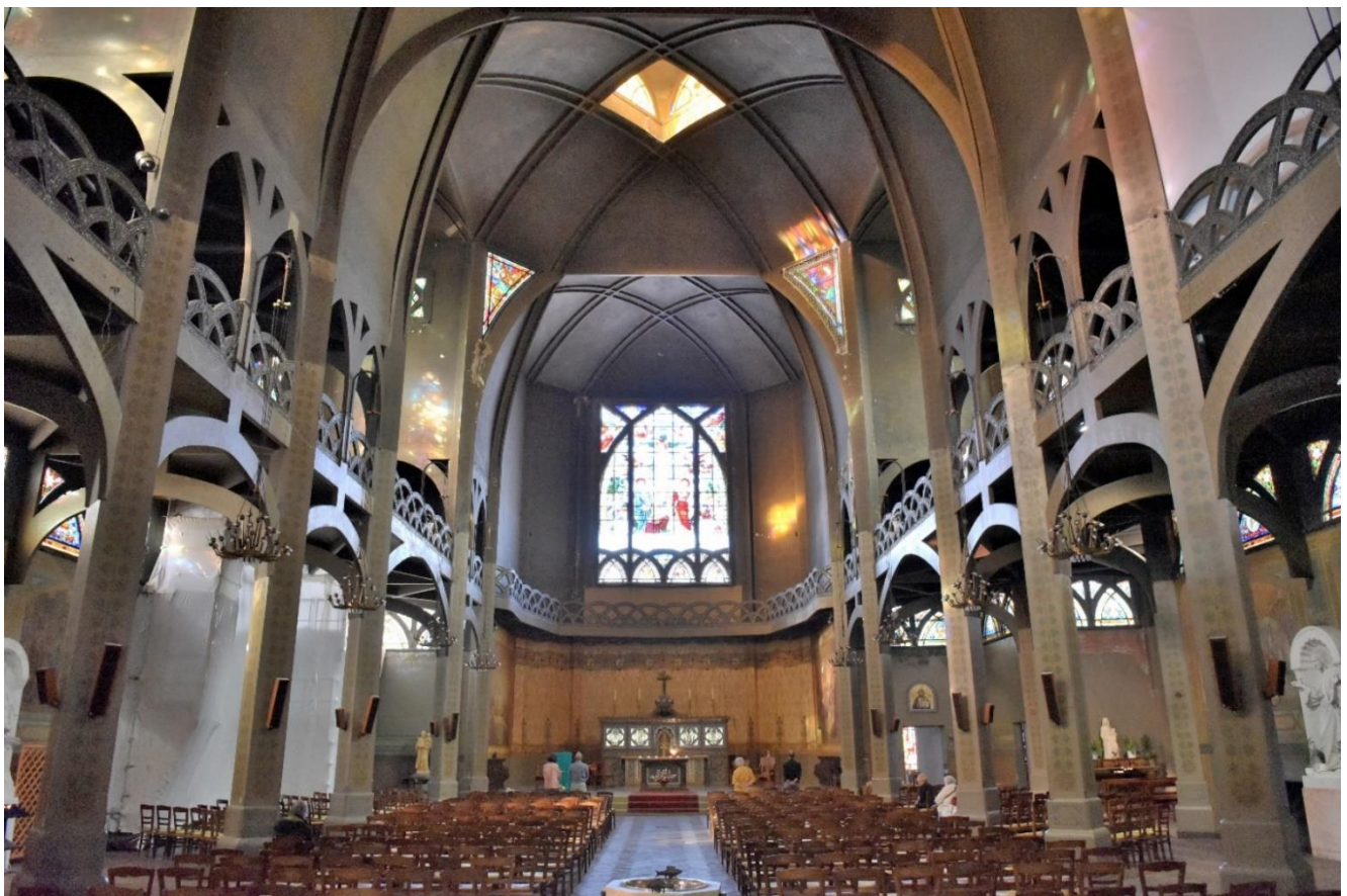
Abb. 84: aufstrebende Stahlbetonkonstruktion in Haupt- und Seitenschiffen mit Blickrichtung zum Chor
