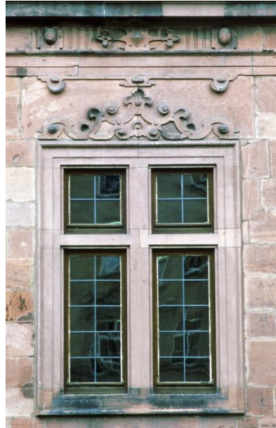
Abb. 8 und 9 Aschaffenburg, Schloss, Wandaufbau, Fenster im Erdgeschoss
