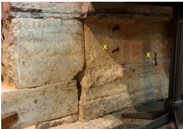
Abb. 13: südöstlicher Vierungspfeiler (Foto R. Vlatten, 2023)
