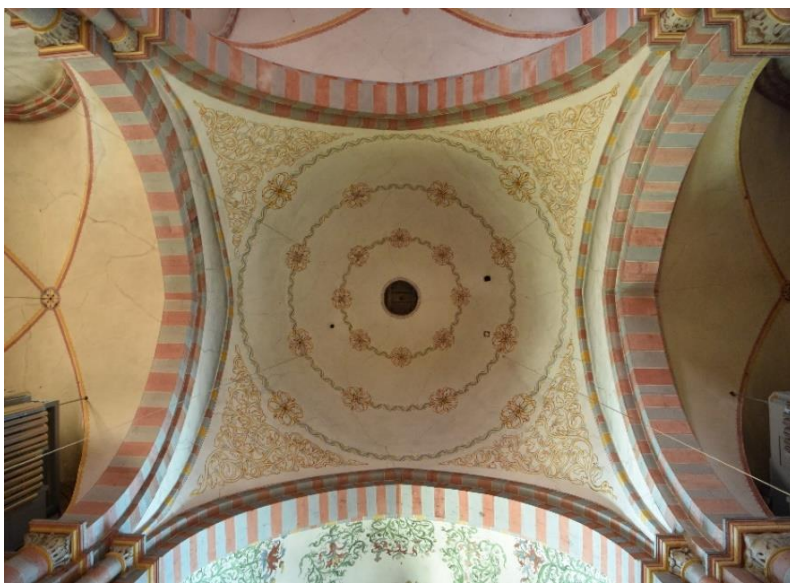
Abb. 24: Vierungsgewölbe (Foto R. Vlatten, 2023)
