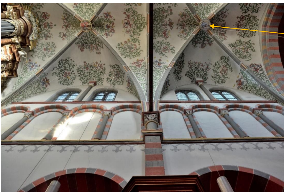
Abb. 31: Wandaufriß Nordseite (Foto R. Vlatten, 2023)
