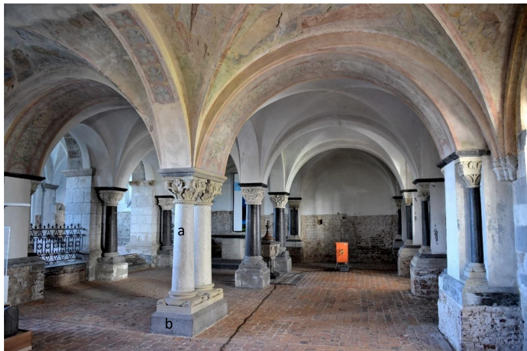
Abb. 103: Blick in die südliche Benediktikapelle. Die gekuppelten Säulen (a) deuten die frühere Trennwand an, während die erhöhten Sockelsteine (b) auf ein ursprünglich höheres Bodenniveau verweisen.
