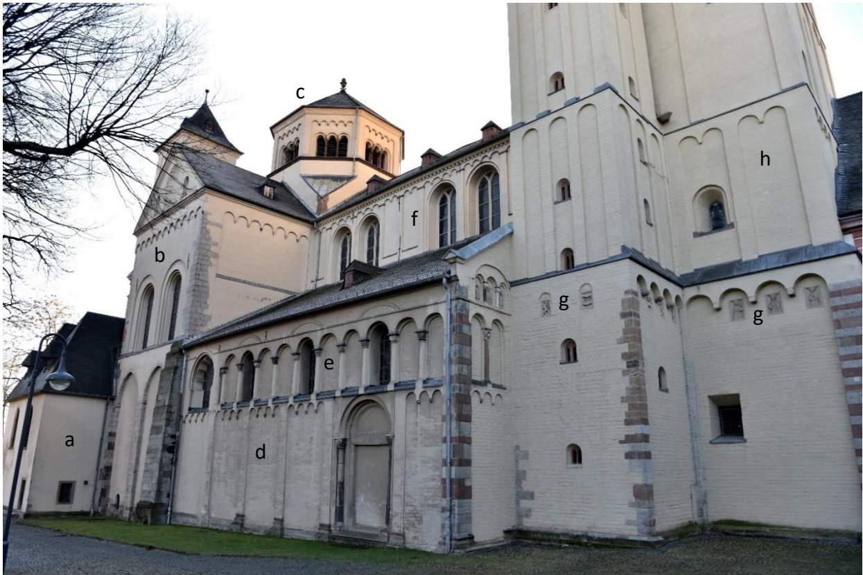
Abb. 28: Nordfassade (Foto R. Vlatten, 2023)
