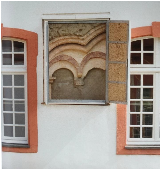
Abb. 54: mittelalterliche Fassade (Foto LVR-Kulturzentrum [a] )
