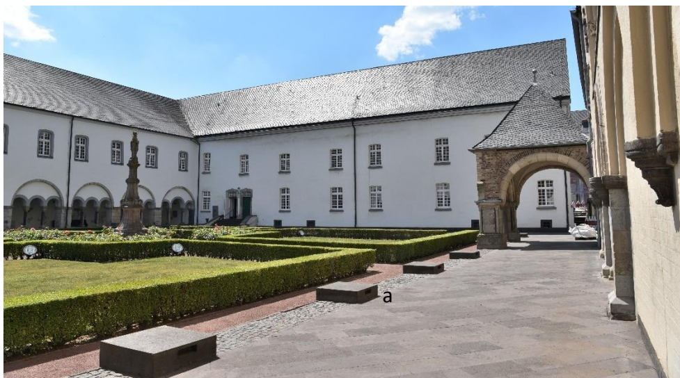
Abb. 42: Blick auf Süd- & Westflügel sowie die Postamente (a) des ehem. Nordflügels (Foto R. Vlatten, 2023)
