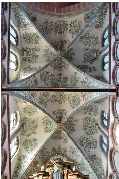
Abb. 25: Langhausgewölbe (Foto R. Vlatten, 2023)
