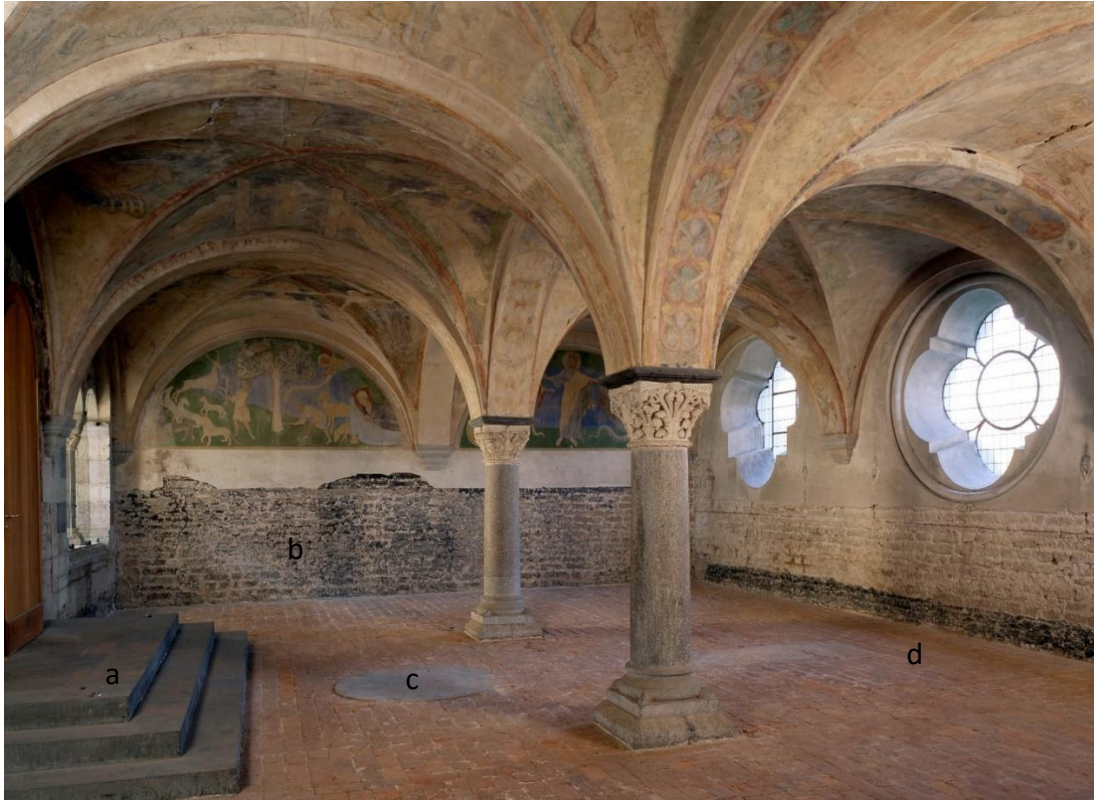
Abb. 46: Kapitelsaal Richtung Nordosten (Foto: LVR-Kulturzentrum Abtei Brauweiler [a] )
