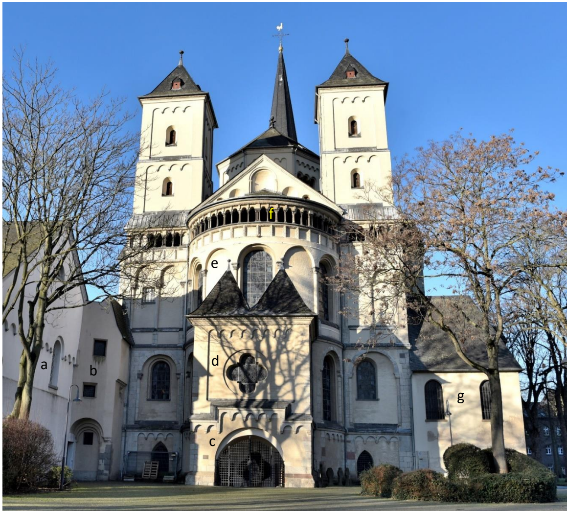
Abb. 27: Ostansicht der Abteikirche (Foto R. Vlatten, 2023)
