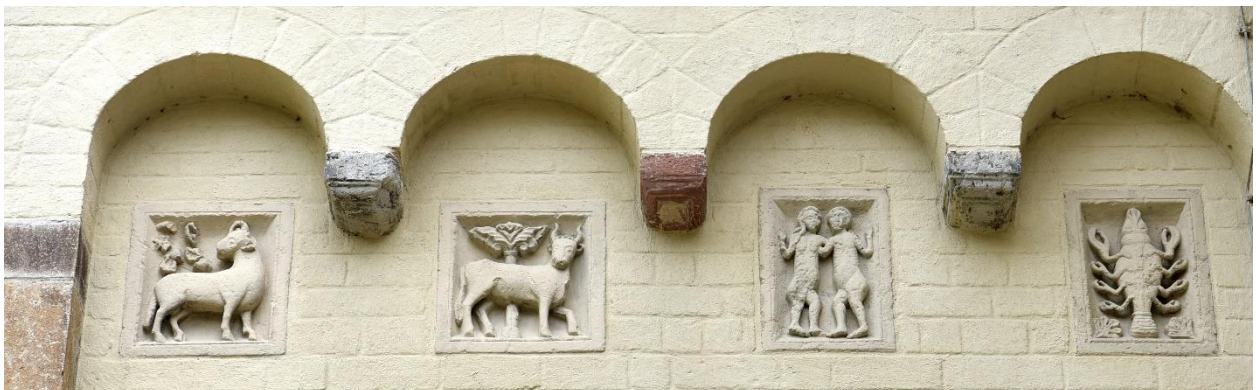
Abb. 14: Kopien der Muldennischenreliefs an der nördlichen Fassade des Nordturms (Foto R. Vlatten, 2023)
