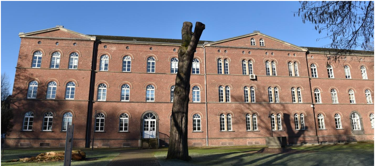
Abb. 9: Frauenhaus im nordwestlichen Teil des Abteiparks mit Mittel- und Seitenrisaliten (Foto R. Vlatten, 2023)
