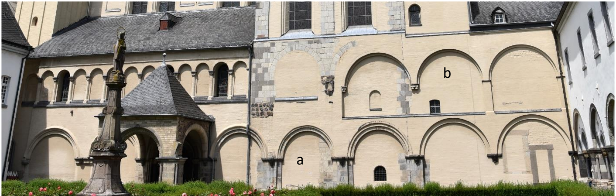
Abb. 5: Nordseite Marienhof mit Resten der Kreuzgangarkaden (a) und der alten Sakristei (b) (Foto R. Vlatten, 2023)
