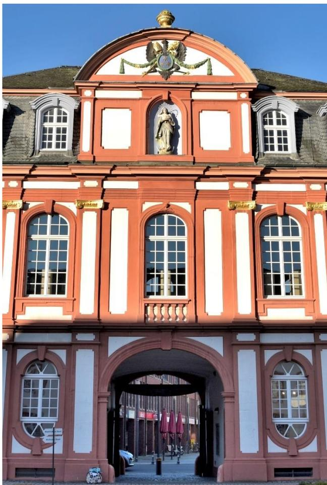
Abb. 68: Mittelrisalit Westflügel Prälaturhof; ovale Fenster im Erdgeschoss weisen Keilsteine am oberen und am unteren Ende auf.
