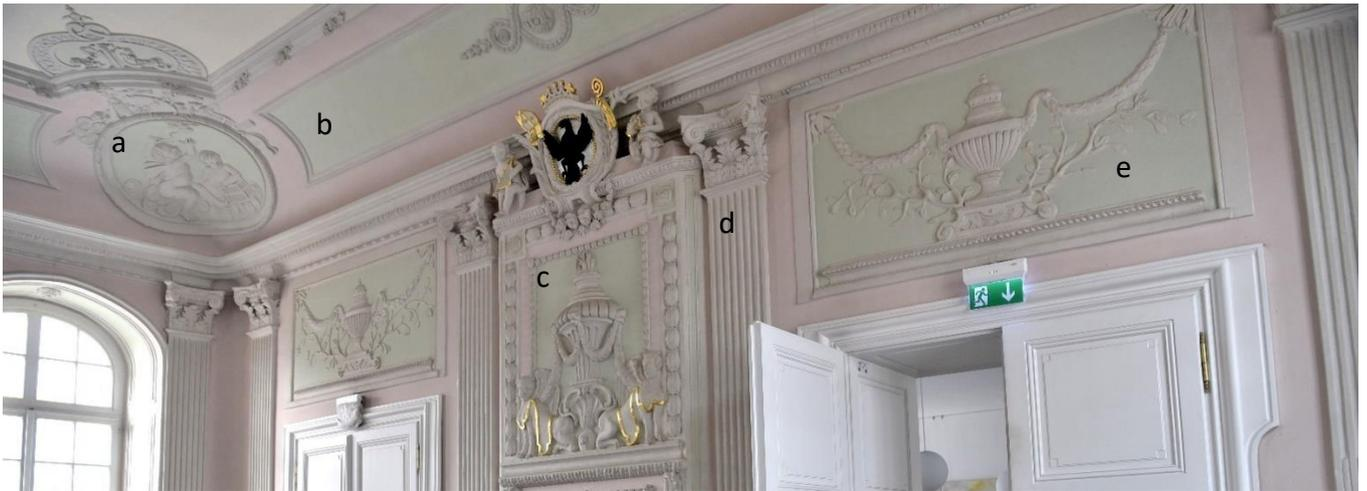
Abb. 56: Deckenvoute (a) mit den Elementen, Kranzgesims (b), Kaminverzierung (c), Komposit-Pilaster (d), stuckierte Supraporte (e)
