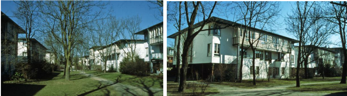
Abb. 22 und 23 München, Wohnanlage „Integriertes Wohnen“ in der Volpini- und Taschnerstraße
