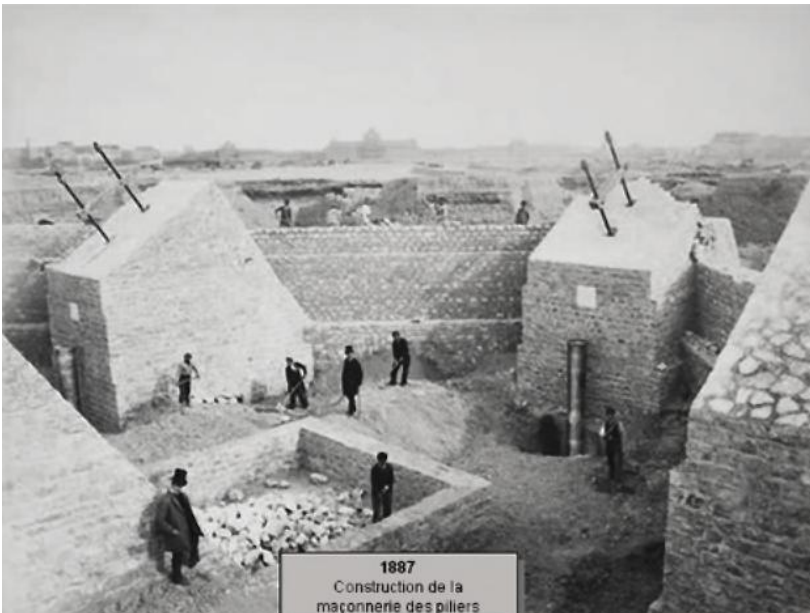
Abb. 7 Paris, Weltausstellung 1889 , Fundamente des Eiffelturms
