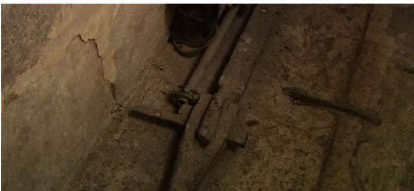
Abb. 1 Amiens, Kathedrale, Ringanker im Mittelschiff, 1497
