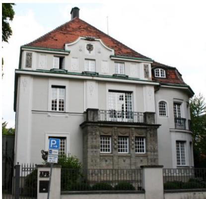
Abb. 5 Villa August Pschorr Möhlstraße 2, 1907-08 Architekt: Eugen Drollinger
