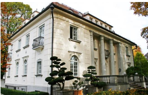
Abb. 16 Villa in der Delpstraße 6 1922-23, Architekten: Heilmann & Littmann
