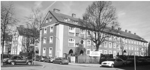
Abb. 13 München, Arbeitersiedlung Alte Heide Häuserzeilen
